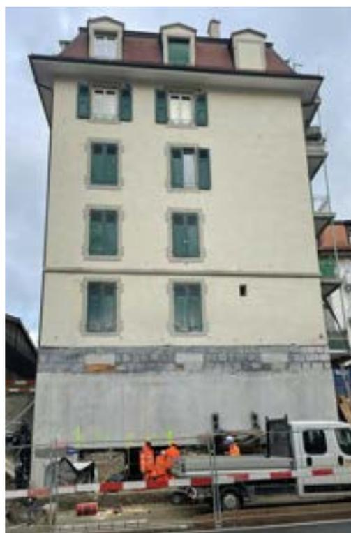
Figure 1 – Vue du bâtiment avant et après travaux de reprise en sous-œuvre
