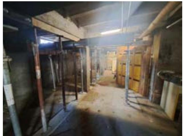
Figure 2 – Zone à surveiller à l'intérieur du bâtiment : 19 points répartis sur le plafond hourdi de la cave
